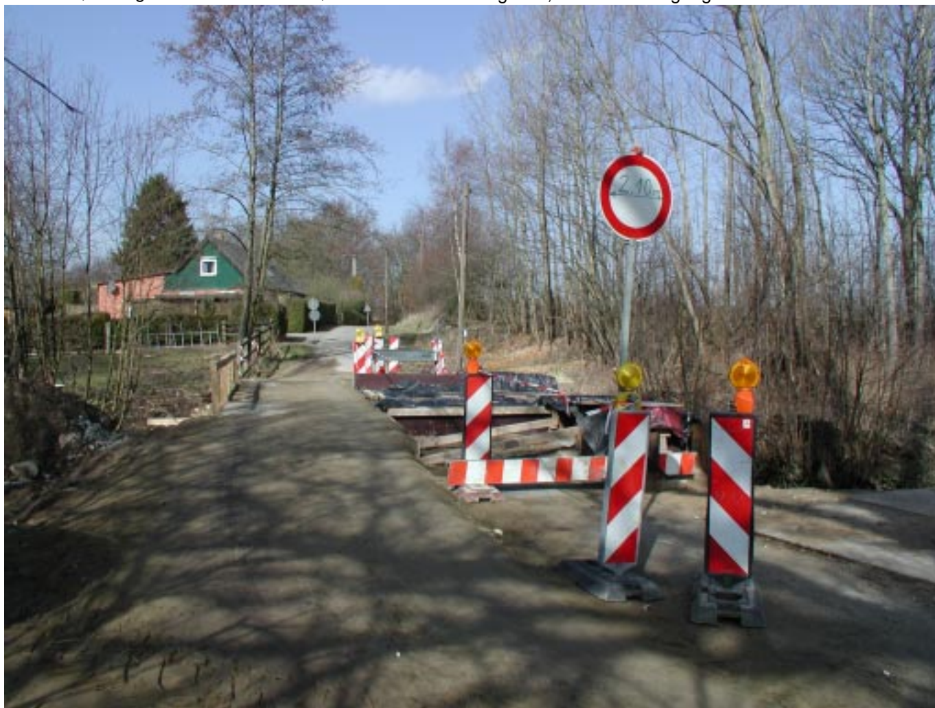
Die Brücke „Zum Moor“ am 8. März. Die eine Hälfte ist fertig. Die Fahrbahnbreite von 2,10 Meter lässt keine größeren Fahrzeuge zu
