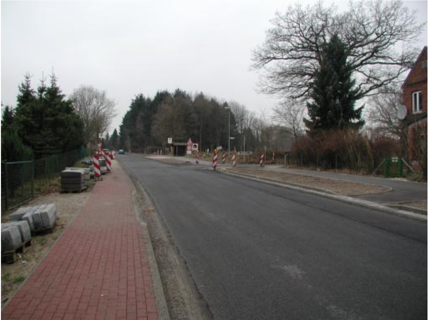
Die Kreisstraße 31 in Lütjensee wurde erneuert. Dabei wurde die Straße tiefer gelegt.
