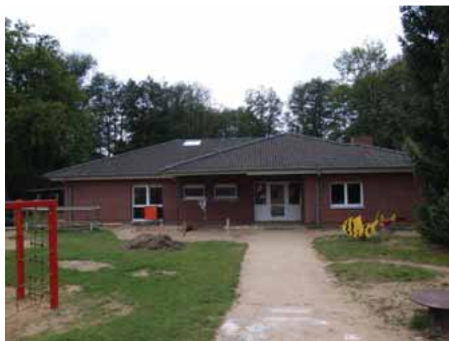
Unser Kindergarten vor Baubeginn
