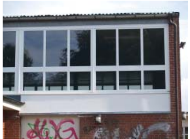
Die Sporthalle bekam moderne Fenster
