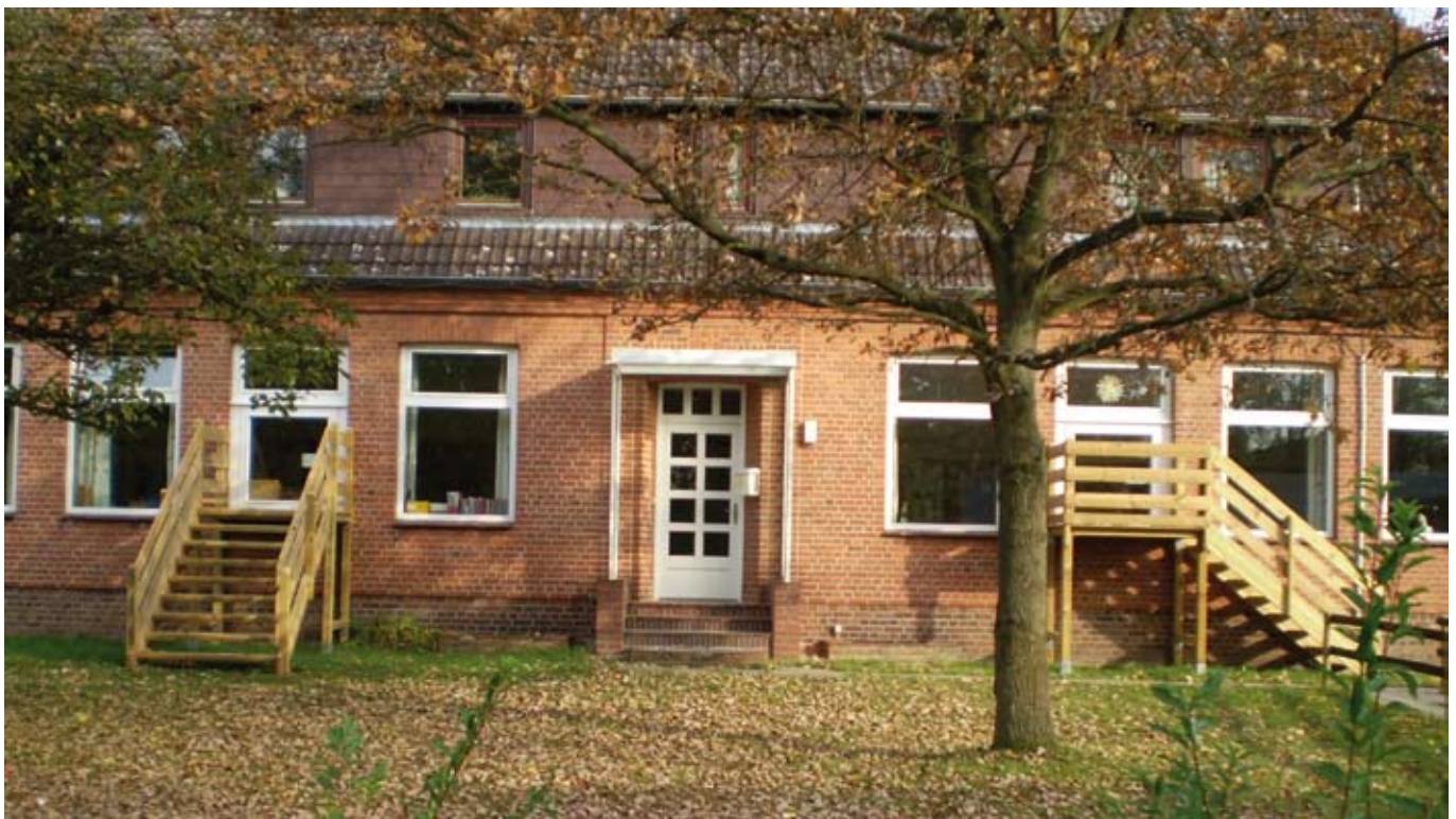
Die neuen Fluchtreppen aus den beiden Klassenzimmern
